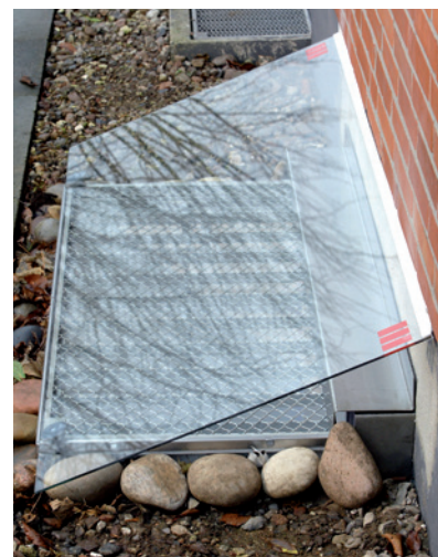
Die ACO Lichtschachtabdeckung aus Einscheibensicherheitsglas (ESG) inklusive Befestigungszubehör und Dichtungsband
