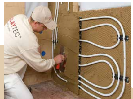
Der Unterputz wird über die Rohrscheitel abgezogen
