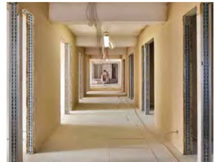
Lehm-Dünnlagen Beschichtung beim BV UN-Campus, Bonn
