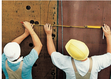
1. Leibungsfenster/Stützkreuz einmessen.
