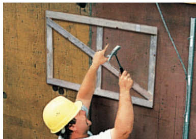
3. Stützkreuz auf der Schalung befestigen.
