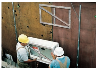
4. ACO Therm® Leibungsfenster auf das befestigte Stützkreuz stülpen und mit den seitlich angebrachten Lochbändern sichern.
