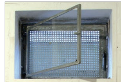
Vor der Renovierung
