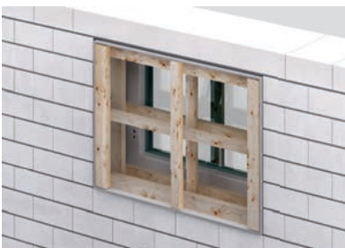
4. Aussteifungen erst nach Erhärten des Mörtels entfernen.
