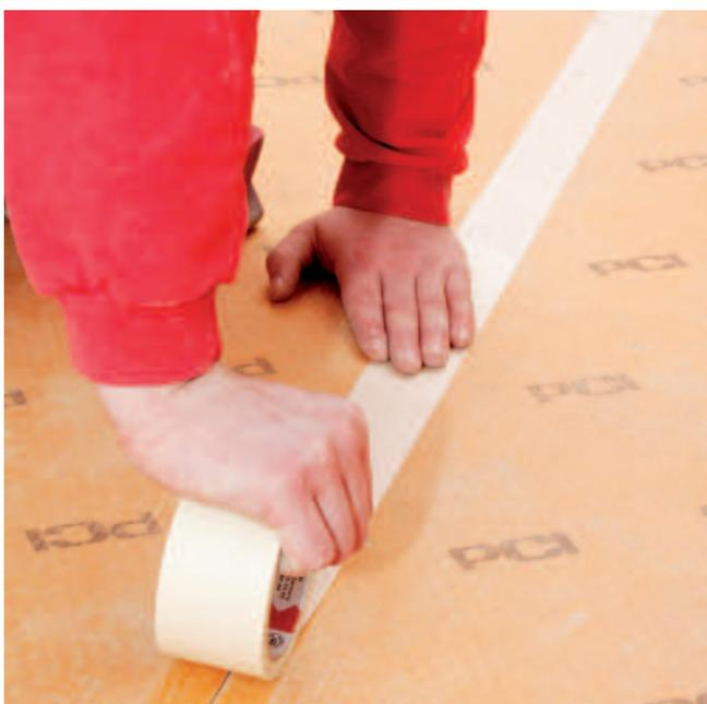
In Trockenbereichen die Stöße mit Kreppband sichern, in Bereichen mit Feuchtigkeitsbelastung mit PCI Pectape abdichten...
