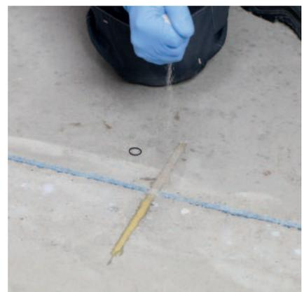
Oberfläche glatt abziehen und bei Bedarf mit Quarzsand 0,3 - 0,8 mm voll deckend abstreuen.
