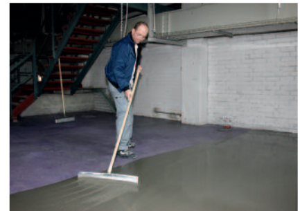
Mit PCI Periplan® Multi läßt sich ein schnell belastbarer Bodenausgleich einfach herstellen
