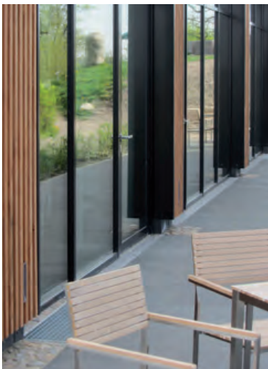
Geschlossene Rinne mit Anschluss an die Entwässerung: Terrasse mit ACO Self® Euroline
