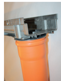
Anschließen des KG Rohres DN 100
