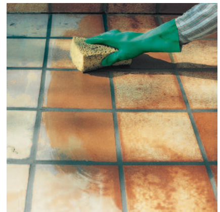
... und anschließend mit einem feuchten Schwamm nachwaschen.
